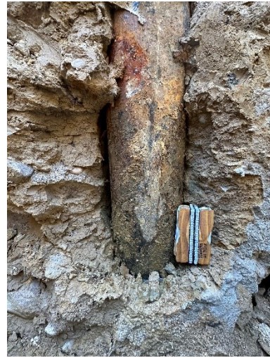
Foto 2. Lahtikaevatud puurkaevu manteltoru ümbrus liivsavi moreenis
