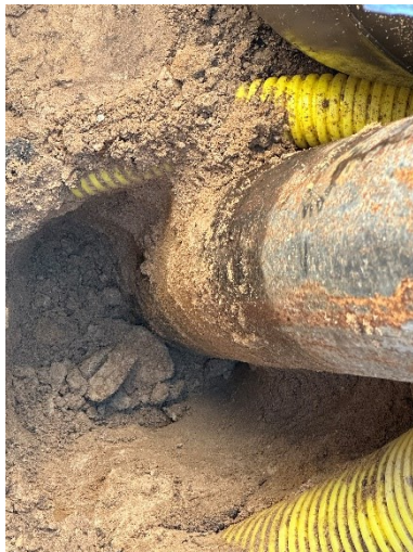
Foto 1. Lahtikaevatud puurkaevu manteltoru ümbrus liivases pinnases
